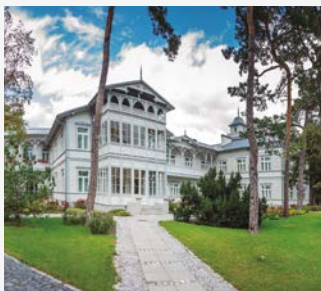
Gurewicz Spa Resort. Hotell - Restaurant - Spa. Otwock, Polen. PACi, VRF og Kontroll.
